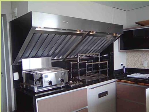
Com sistema controlador de odores integrado, capta em seus módulos internos, através dos dois estágios de retenção (macro e micro particulados), os vapores gordurosos emitidos.
