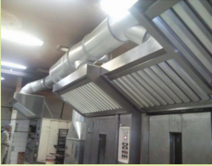
As coifas exaustoras auxiliam na retirada da fumaça e através dos filtros inerciais, condensam a gordura para que haja a drenagem, coletaagem e descarte.
