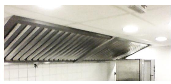
Em conformidade com normas ABNT NBR 14518:2019 e ASHRAE, também possui uma coifa com aspiração frontal ou lateral "Jet Blocker" e tecnologia Hayashi de jato de captura, garantindo alta eficiência na eliminação de odores e segurança com sistema antichamas.
