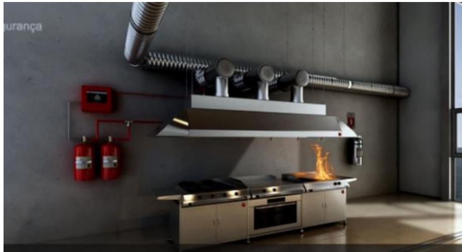
Equipamento fabricado em aço inox escovado AISI 430, com lamina condensadora de vapor d'água, botão interruptor para acionamento do sistema, luminárias, calha e dreno.
